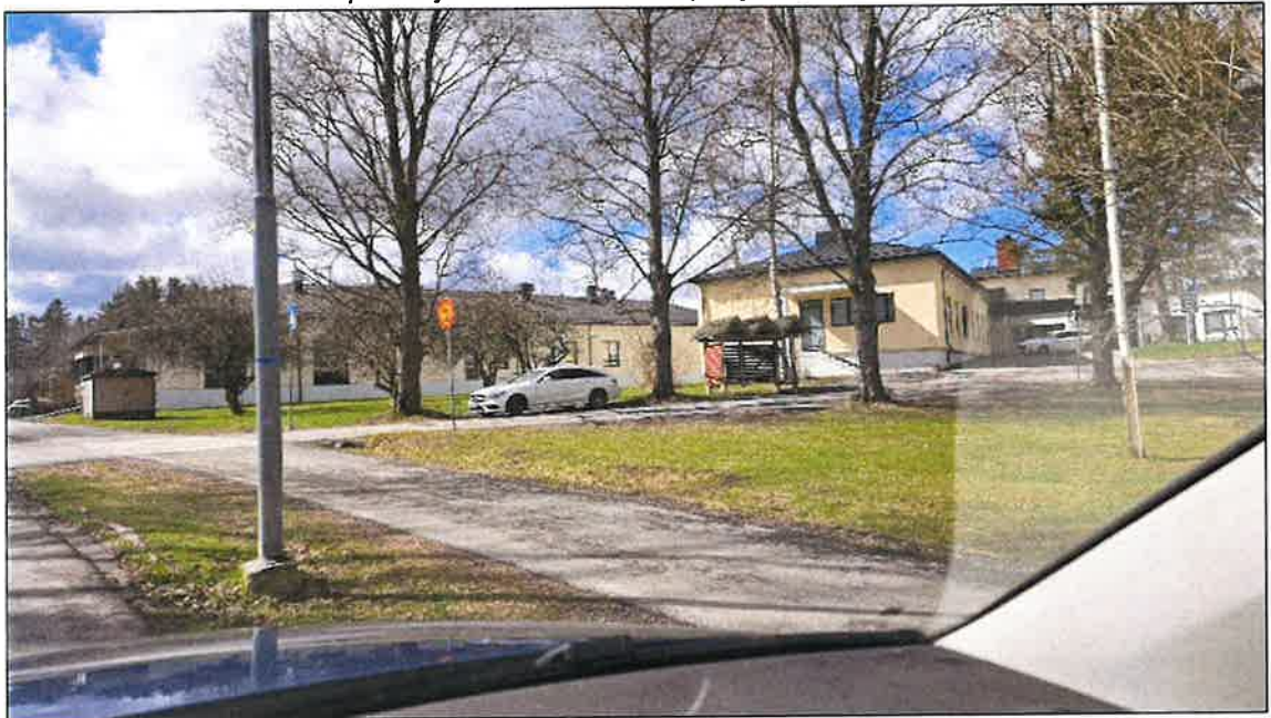
Kuva 3. Sosiaali- ja terveysasemarakennus
